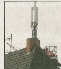
Antennenarbeiten Ende November. • Foto: Mroß
